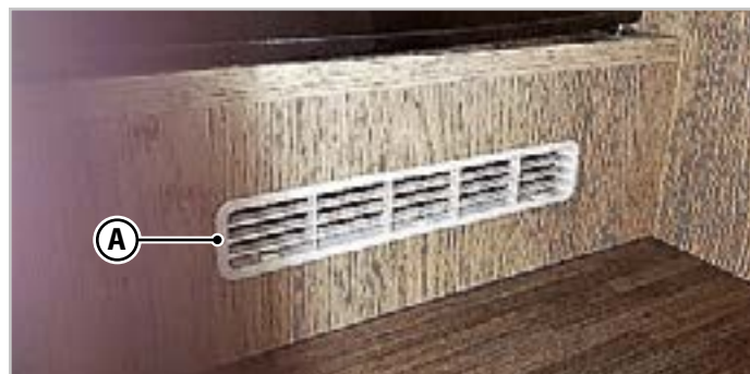
Rys.6.1 - Stałe otwory wentylacyjne
