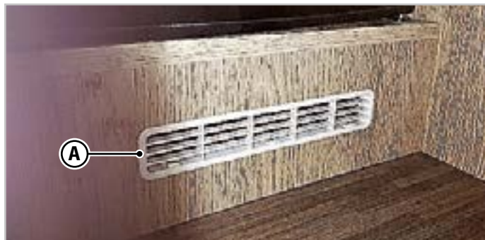
sl.6.1 - Stalni ventilacijski otvori
