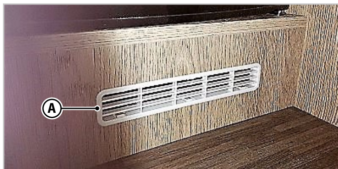
Fig.6.1 - Aberturas de ventilación permanentes
